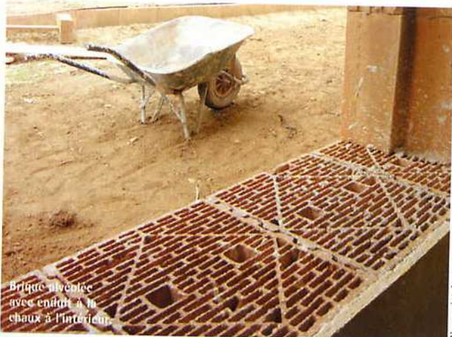
La technique de la maçonnerie roulée permet de limiter au maximum l'épaisseur du mortier.
