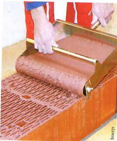
La technique de la maçonnerie roulée permet de limiter au maximum l'épaisseur du mortier.
