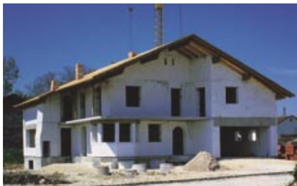
Construction en béton cellulaire
